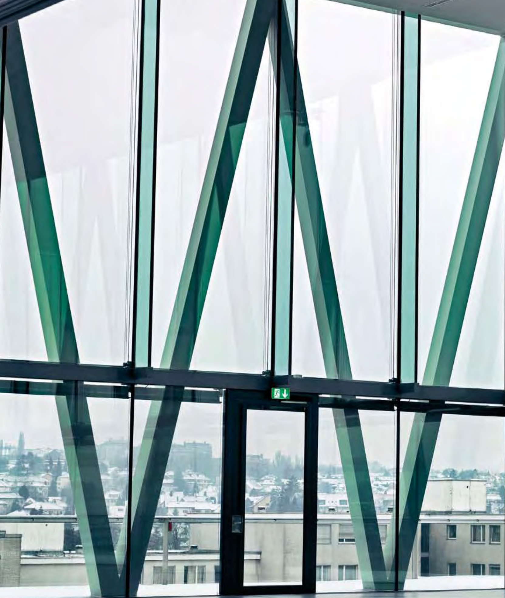
Turnhalle Schulhaus Leutschenbach, Zürich
