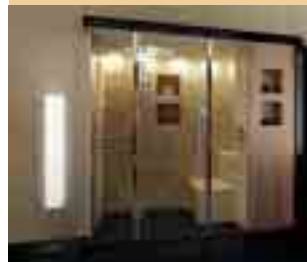
Bagno di vapore
