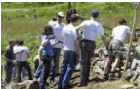
Trockenmauerbau in Ardez – eine anstrengende, aber lehrreiche Tätigkeit für die Volunteers in Zusammenarbeit mit dem WWF Schweiz.
