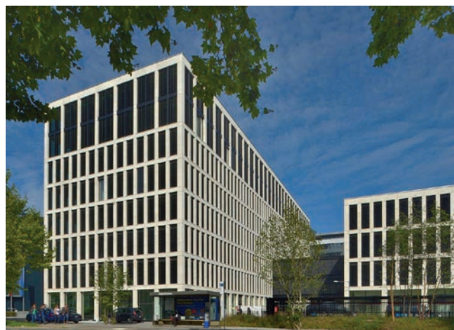
Das Bürogebäude «Foyer» Zug ist mit greenproperty, Minergie-ECO und LEED Platinum zertifiziert und gilt als Vorzeigeobjekt für nachhaltiges, ökologisches Bauen. Copyright: leistungsfotografie.ch
